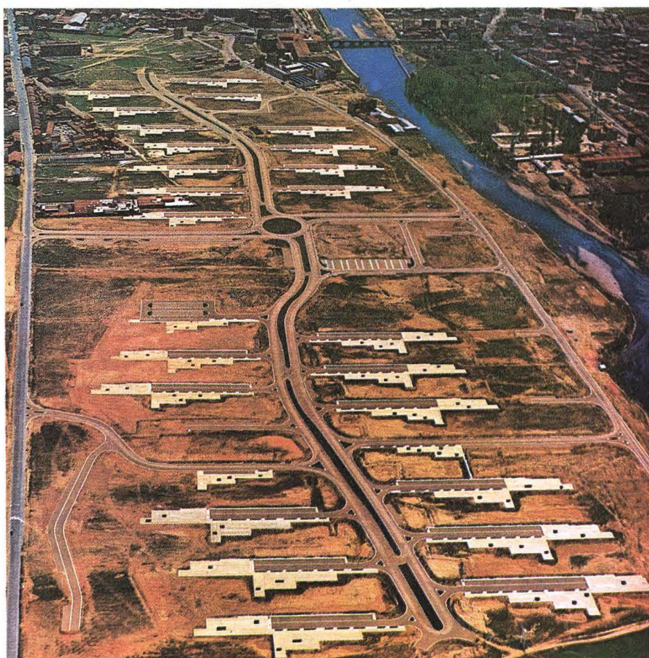
Gerencia de Urbanización. Polígono Residencial. Eras de Renueva. León.
